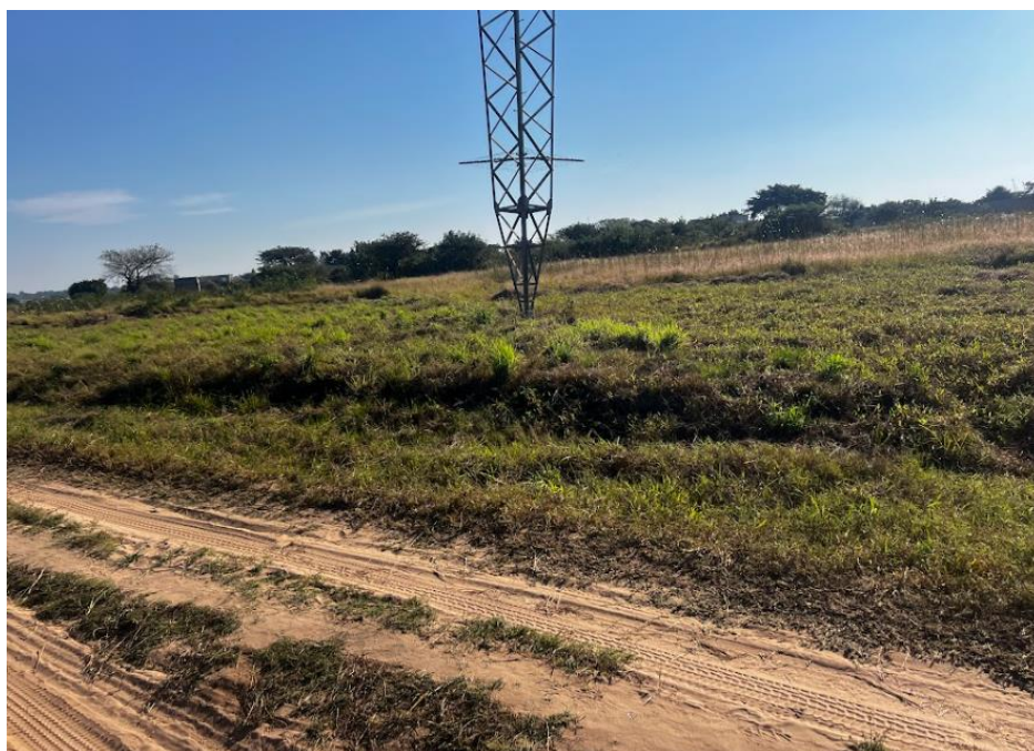
Figura 7: Estado da Torre 320
